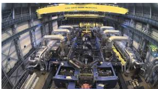
Turbína, kterou pohání pára z reaktoru
